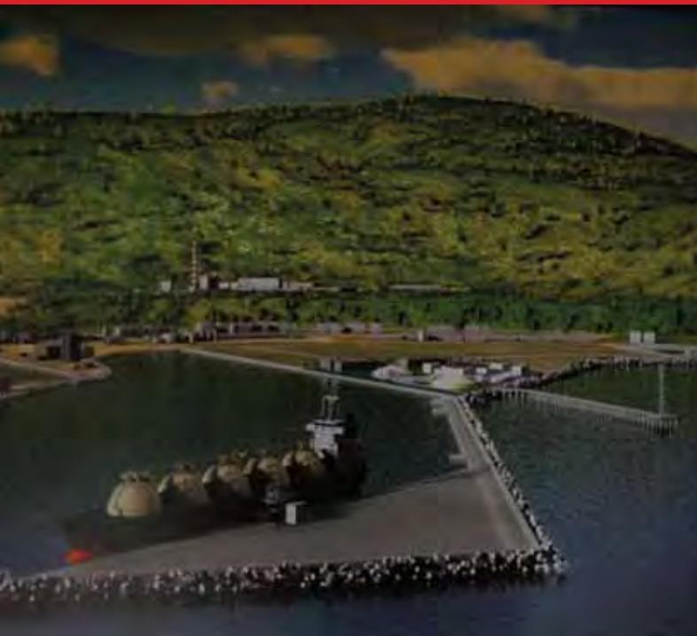
Oltre al vento e al sole anche il gas può dare una mano a produrre energia pulita. In Sicilia sono previsti due rigassificatori, a Priolo e Porto Empedocle. Sono impianti che riportano il gas naturale liquefatto allo stato gassoso grazie ad un semplice scambio termico, senza alcun processo di combustione.
